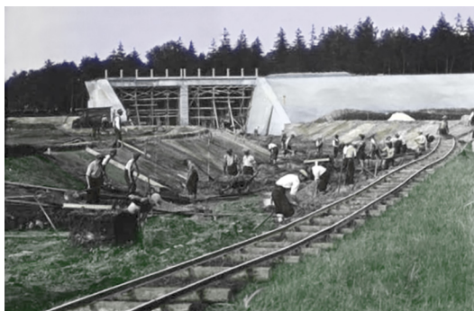
Rys. 20. Kozłowa Góra budowa zbiornika (1938 r.). Zbiory: archiwum inżyniera Jana Stonawskiego, projektanta i głównego budowniczego zapory.
