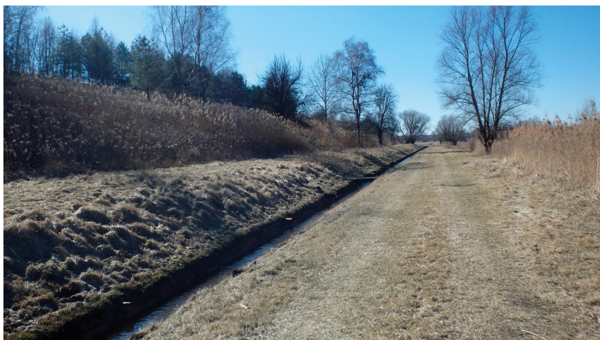
Rys. 13. Strona odpowietrzna obwałowania głównego kwatery nr 3 mokrego składowiska odpadów, wykonanego z odpadów paleniskowych (marzec 2022 r.).
