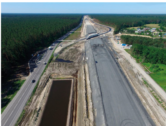
Rys. 11. Widok nasypu drogi ekspresowej S19 wykonanego z odpadów paleniskowych z morkiego składowiska odpadów „Jelnia” (maj 2020 r.) ( https://s19-janowlubelski-lazek.pl ).
