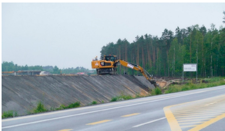
Rys. 10. Formowanie skarpy nasypu drogowego drogi ekspresowej S19 wykonanego z odpadów paleniskowych na odcinku Janów Lubelski – Łążek (maj 2020 r.) ( https://s19-janowlubelski-lazek.pl ).
