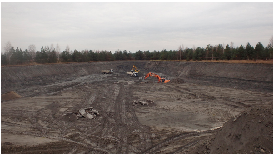
Rys. 3. Kwaterna nr 4N-W mokrego składowiska odpadów paleniskowych „Jelnia” – wybieranie i wywóz odpadów (listopad 2020 r.).
