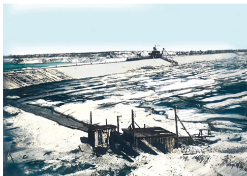
Rys. 19. Goczałkowice budowa zbiornika (1950-1955). Zbiory własne GPW S.A.
