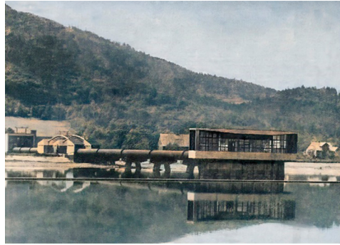
Rys. 21. Czaniec – ujęcie wody (1971 r.). Zbiory własne GPW S.A.
