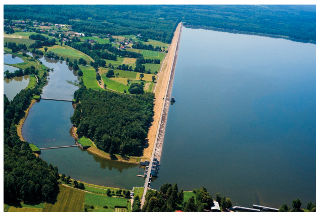
Fot. 2. Zapora czolowa – widok od strony północnej (A. Siudy).
