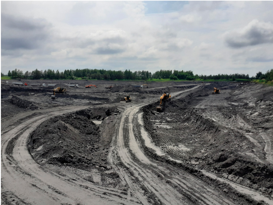
Rys. 2. Kwaterna nr 4S-E mokrego składowiska odpadów paleniskowych „Jelnia” – wybieranie i wywóz odpadów (czerwiec 2020 r.).
