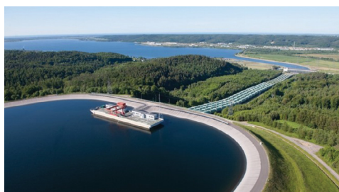
Rys. 3. Elektrownia wodna Żarnowiec [ https://pgeeo.pl ]
