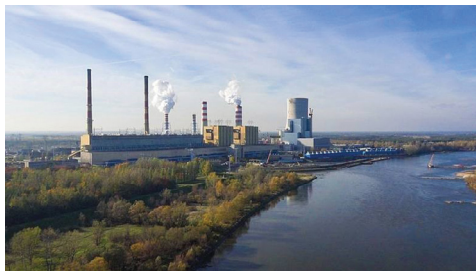
Rys. 1. Elektrownia Kozienice [ https://echodnia.eu ]
