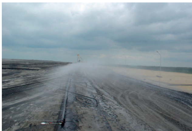
Rys. 3. Pracująca kurtyna wodna w okresie silnego wiatru [archiwum KGHM]
