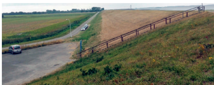
Rys. 4. Widok na skarpe odpowietrzną wału [Google Maps]
