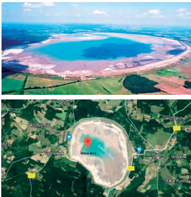
Rys. 1. Widok zbiornika OUOW „Żelazny Most” [www.polkowice.eu]; widok satelitalny obiektu z zaznaczeniem lokalizacji wieży W11 [Google Maps]
