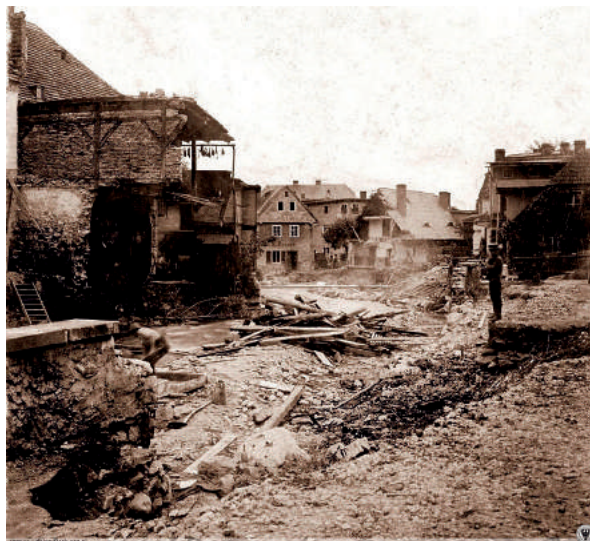
Rys. 3. Zniszczenia w Kowarach po powodzi 1897 r., dzisiejsza ul. Stanisława Staszica [https://dolny-slask.org.pl/511605,Kowary,1897_Powodz_w_Kowarach.html]
