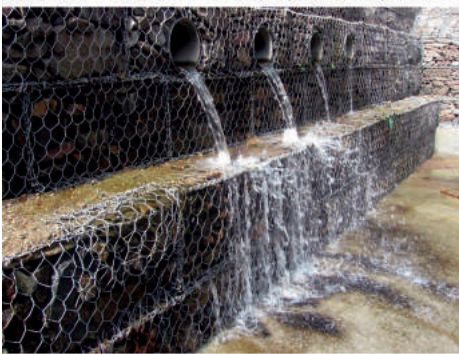
Rys. 8. Budowla regulacyjna na potoku Jedlica [fot. M. Kuc, Maccaferri Polska Sp. z o.o.]
