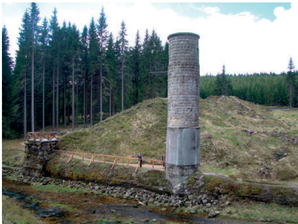
Rys. 5. Zapora Bilá Desná, zniszczona w wyniku katastrofy w 1916 r. – stan obecny [fot. J. Winter]
