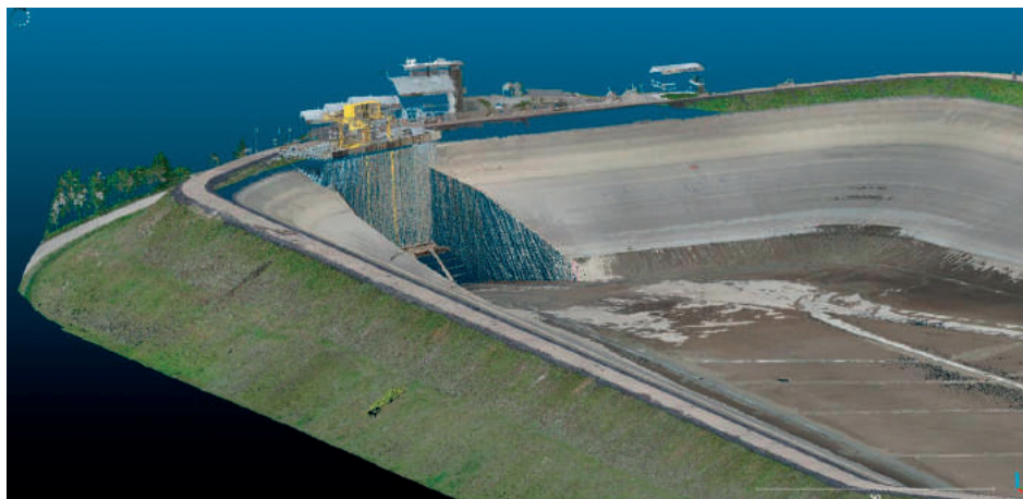
Rys. 1. Pokolorowana chmura punktów, zbiornik Porąbka Żar w trakcie opróżnienia zbiornika [opracowanie archiwalne OTKZ]
