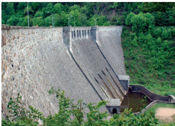
Rys. 12. Zapora w Lubachowie [fot. J. Winter]
