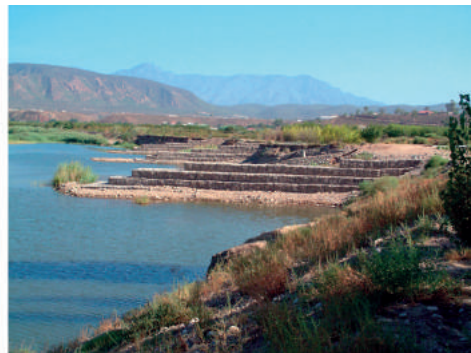
Rys. 9. Ostrogi gabionowe [Officine Maccaferri Italia S.r.l.]
