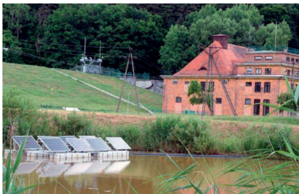
Rys. 6. Pływająca elektrownia PV w zbiorniku przy elektrowni w Łapinie
