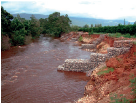
Rys. 9. Ostrogi gabionowe [Officine Maccaferri Italia S.r.l.]
