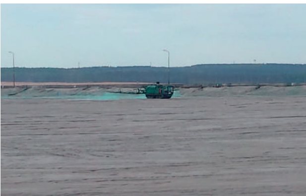
Rys. 6. Aplikacja powłoki polimerowej na plażach OUOW „Żelazny Most” [archiwum KGHM]
