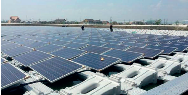
Rys. 4. Moduły pływakowe w systemie Hydrelio©Technology
