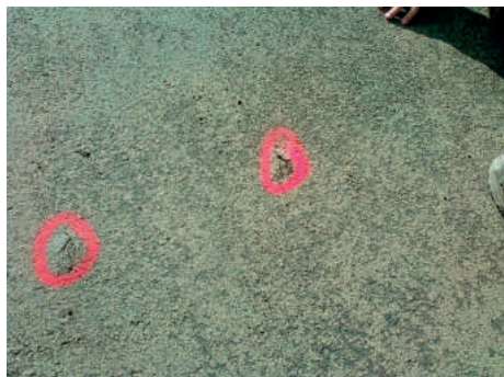
Fot. 7. Uszkodzenia warstwy szczelnej – początkowa faza wzrostu pęcherza rosnącego [fot. Z. Kledyński, maj 2013]
