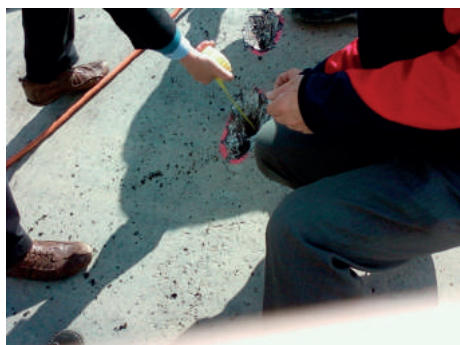
Fot. 8. Naprawa warstwy w miejscu pęcherza rosnącego – stan po wykuciu uszkodzonego materiału [fot. Z. Kledyński, maj 2013]
