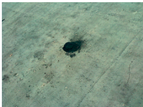
Fot. 9. Naprawa warstwy w miejscu pęcherza rosnącego – stan po wypełnieniu ubytku [fot. Z. Kledyński, maj 2013]
