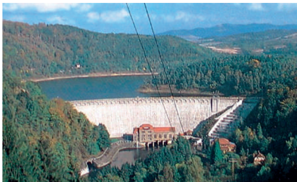
Rys. 10. Zapora i Zbiornik Pilchowice [fot. J. Winter]
