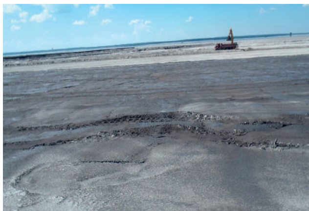
Rys. 4. Fragment plaży zastabilizowany emulsją asfaltową [archiwum KGHM]
