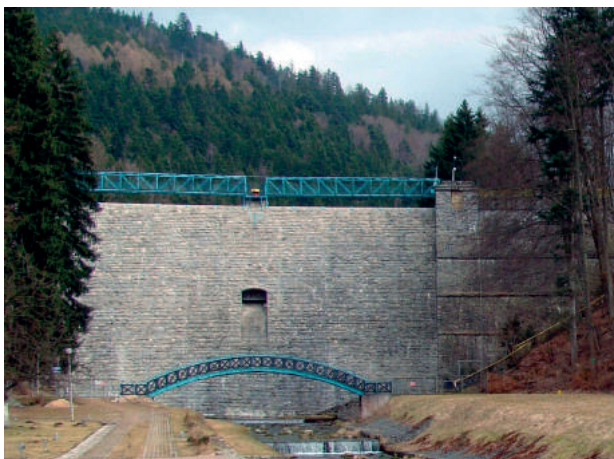
Rys. 6. Zapora suchego zbiornika w Międzygórzcu [fot. J. Winter]
