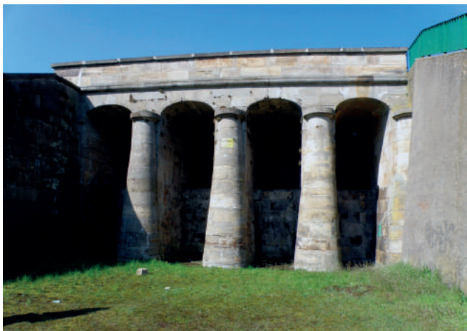
Rys. 1. Zapora Brody Ilżeckie na rzece Kamiennej z kamiennym przelewem – pozostałością obiektu zniszczonego w powodzi 1903 r. – wkomponowanym w skarpe odpowietrzną [fot. P. Kuźniar]
