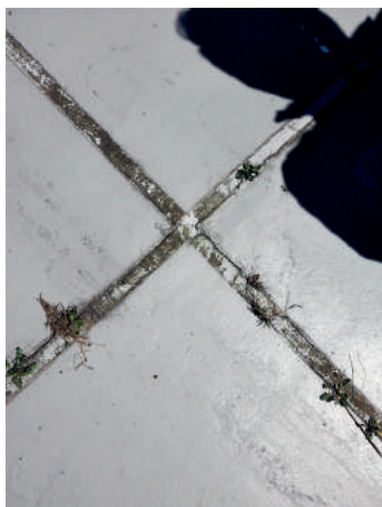
Rys. 7. Rozwój roślinności w rysach wypełnienia dylatacji
